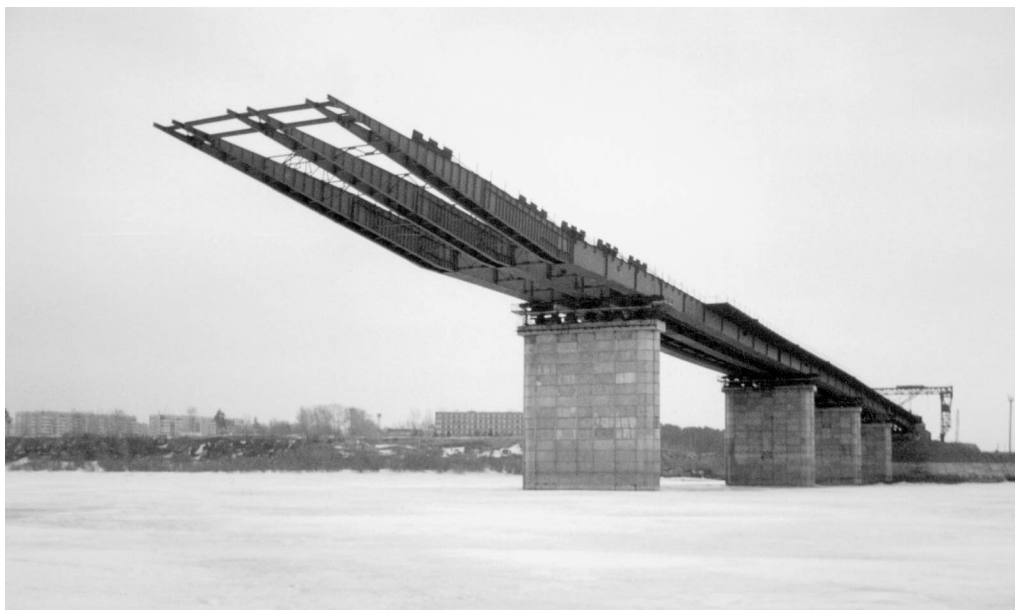
Рис. 1. Трехбалочная консоль пролетного строения
