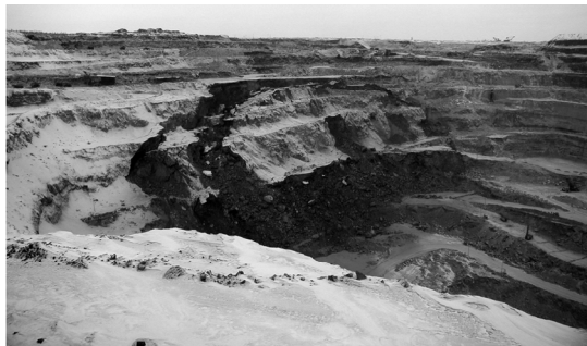
Рис. 1. Обрушенный участок борта карьера “Юбилейный” (Западная Якутия, пос. Айхал) в мерзлых породах [1]
