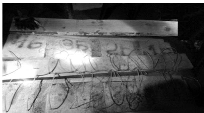
Рис. 3. Подготовленная к взрыву серия блоков со смонтированной взрывной сетью ДШ
