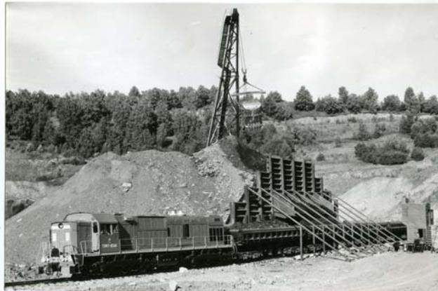
Рис. 2. Общий вид бункерно-экскаваторного перегрузочного пункта
