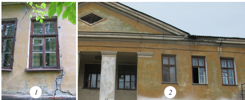
Рис. 1. Повреждения конструкции здания с лицевой стороны (фото С. В. Усанова): 1 — трещины на первом этаже в левом крыле; 2 — повреждения на втором этаже в центральной части
