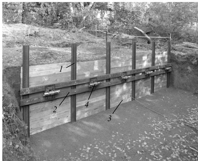
Рис. 12. Усиленное Э-анкерами ограждение котлована: 1 — стойка; 2 — силовой пояс; 3 — забирка; 4 — оголовок Э-анкера с натяжным устройством
