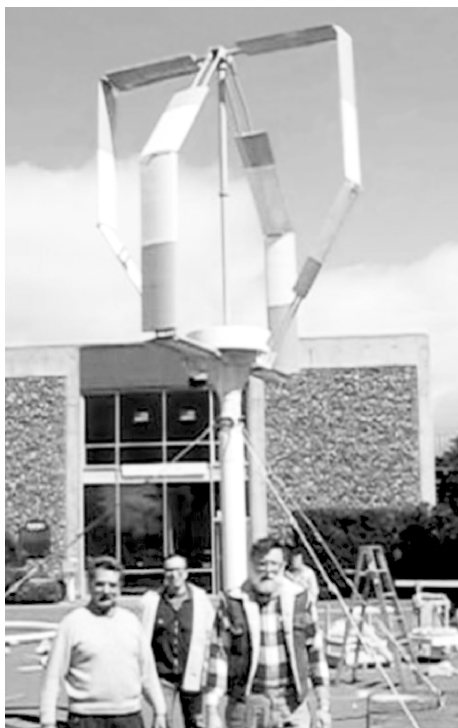
Рис. 1. 4-лопастная двухъярусная ВЭУ мощностью 1 кВт.
