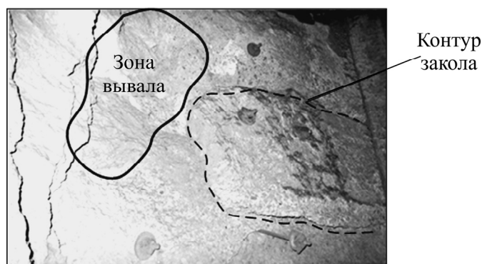
Рис. 1. Нарушения целостности бетонной крепи шахтного ствола
